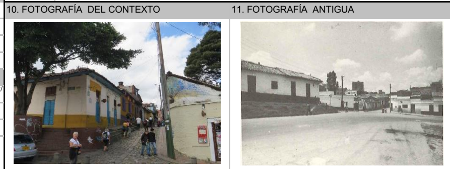
Fuente: Equipo Fotografía PEMP Patrimonio Inmueble
