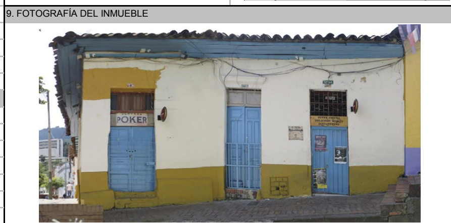
Fuente: Equipo Fotografía PEMP Patrimonio Inmueble
